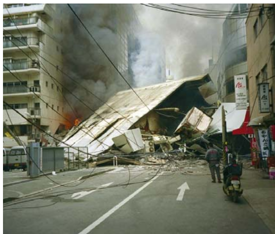
Kompletně zničená betonová budova při zemětřesení v Kóbe dne 17. ledna 1995. Trosky blokují ulici, hasiči mají špatný přístup k požáru. Jediná dostupná voda k hašení dalších 150 požárů ve městě byla v cisternách požárních vozů. Foto: R. Hutchison, U.S.G.S.
