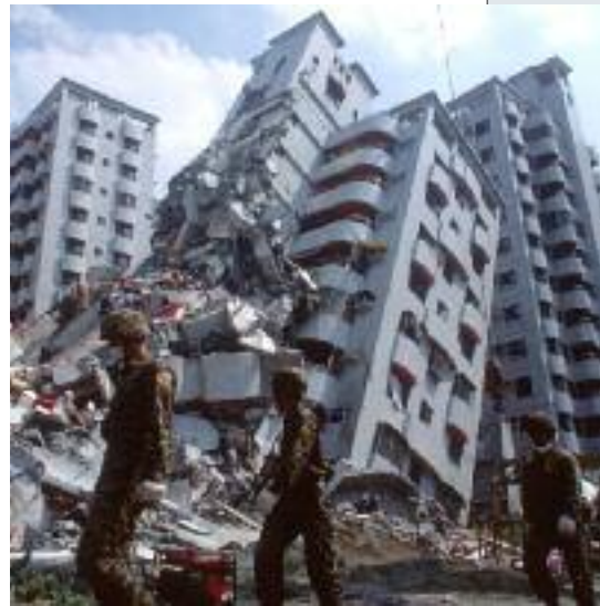
» V oblastech častých zemětřesení (např. na Tchajvanu – na snímku) je důležité stavět domy tak, aby vydržely obvodové zdi a lidé nezůstali uvěznění uvnitř
